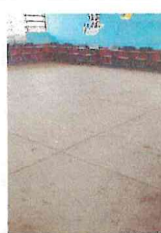
Foto 4: Aula con piso de torta de concreto para colocar piso ceramico
